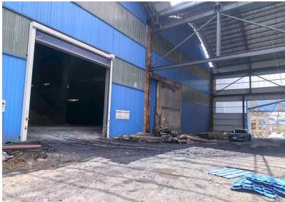
5 号原料棚照片
